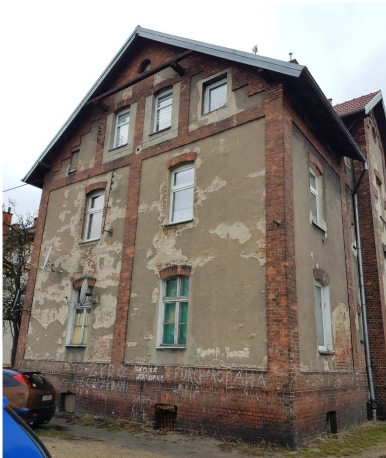
Fot. 3. Elewacja północno-zachodnia
