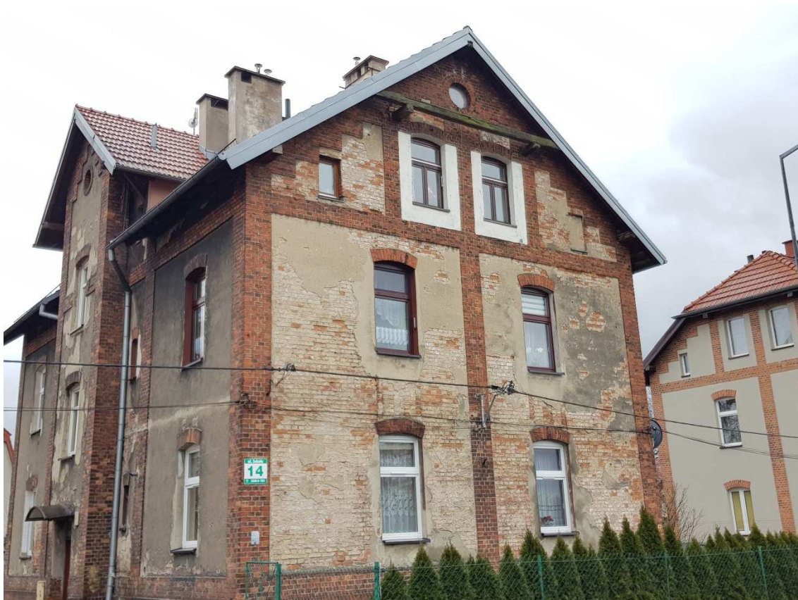
Fot. 4. Elewacja południowo-wschodnia
