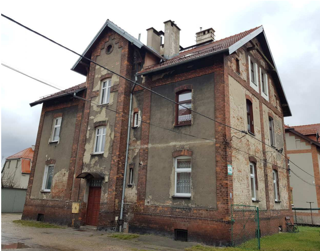
Fot. 1. Elewacja północno-wschodnia
