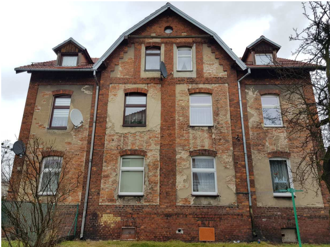
Fot. 2. Elewacja południowo-zachodnia
