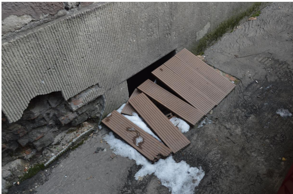
Rys. 30. Prowizoryczne zabezpieczenie okna piwnicznego [1.4].
