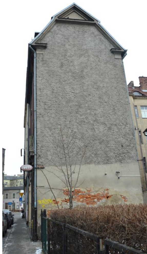
Rys. 13. Elewacja szczytowa oficyny 1 [1.4.].
