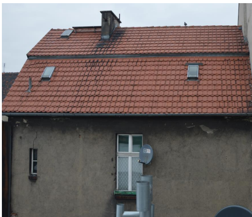
Rys. 11. Elewacja południowo – wschodnia i dach oficyny 1 [1.4.].
