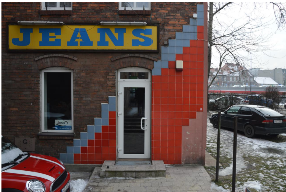
Rys. 14. Elewacja północno – zachodnia – wejście do lokalu usługowego [1.4.].
