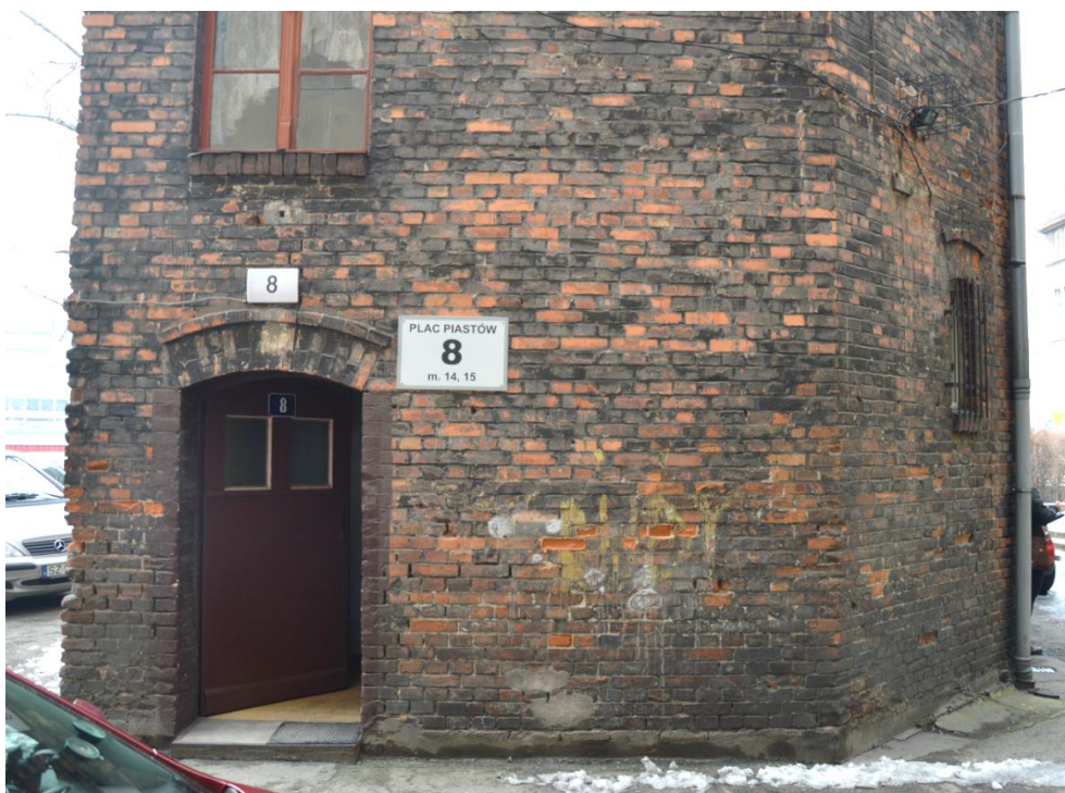
Rys. 17. Elewacja północno – wschodnia – wejście do klatki schodowej [1.4.].
