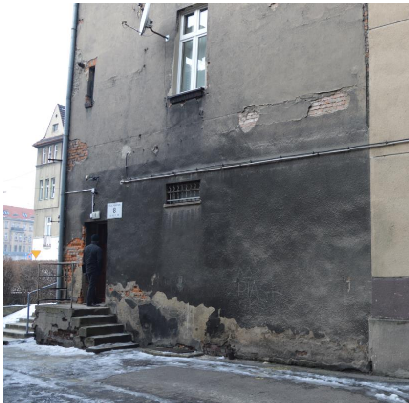
Rys. 12. Elewacja południowo – wschodnia oficyny 1 [1.4.].
