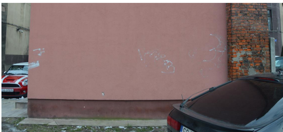
Rys. 38. Zabrudzenia i napisy graffiti na ocieplonej ścianie szczytowej; wypłukanie spoin komina [1.4].
