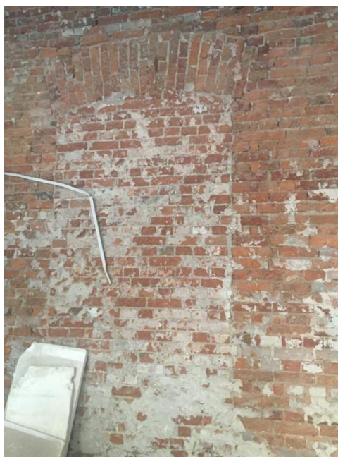
Rys. 59. Zamurowany otwór okienny – widoczne nadproże ceglane [1.4].
