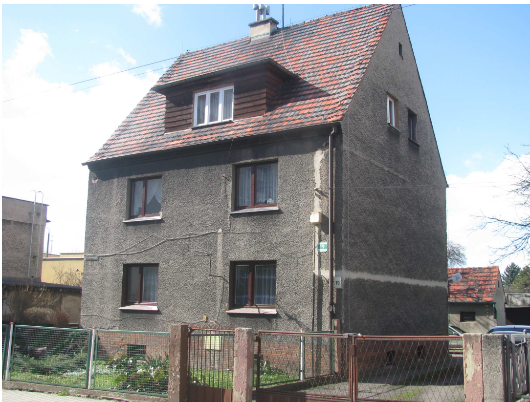
fot. 2 Widok budynku od strony wschodniej
