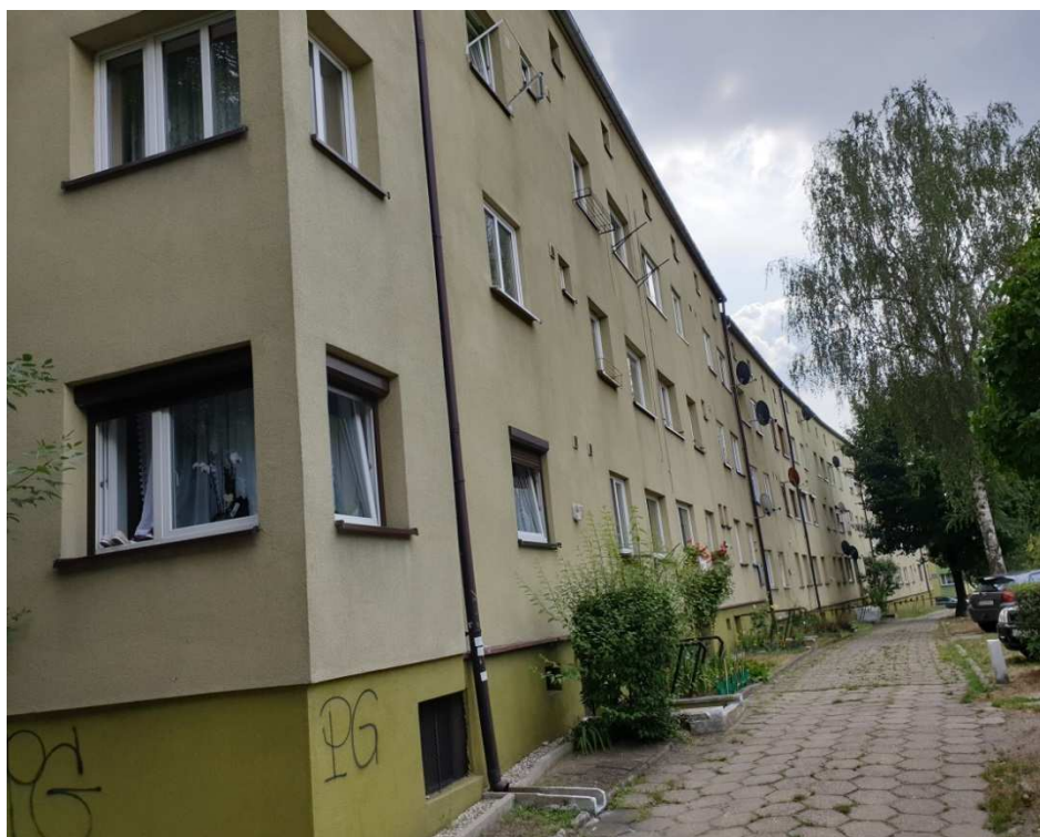
Fot. 2. Elewacja od podwórza – południowo-zachodnia
