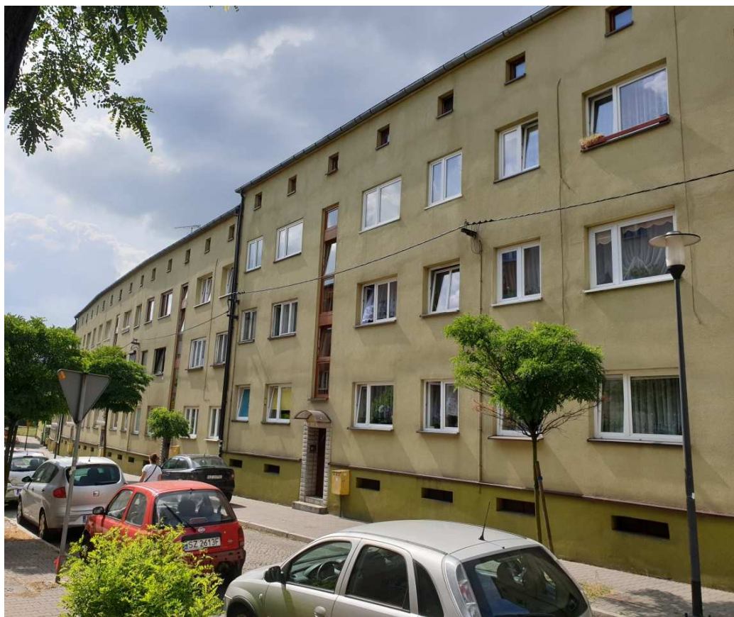
Fot. 1. Elewacja frontowa – północno-wschodnia
