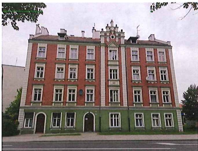
Fot. 1 Elewacja południowa (frontowa)
