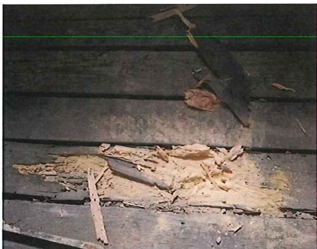
Fot. 3 Żerowisko z widocznym kopczykiem mączki drzewnej i otworami wylotowymi
