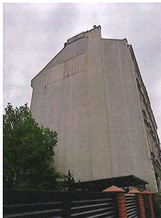
Fot. 4 Elewacja zachodnia
