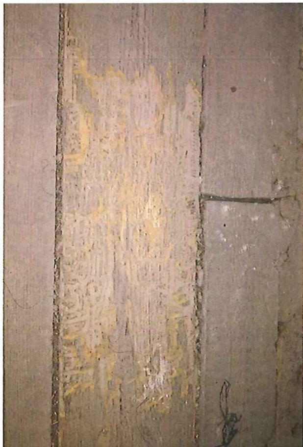
Fot. 5 Charakterystyczne wydrążone tunele
