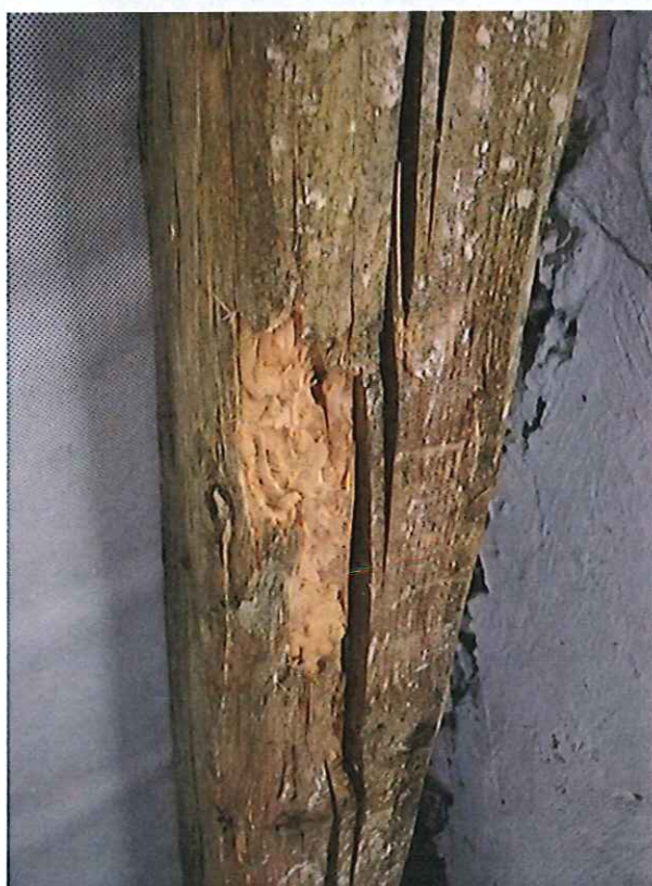
Fot. 21 Słup S11 - Rysy prostopadłe o bardzo dużym rozwarciu oraz żerowisko owadów
