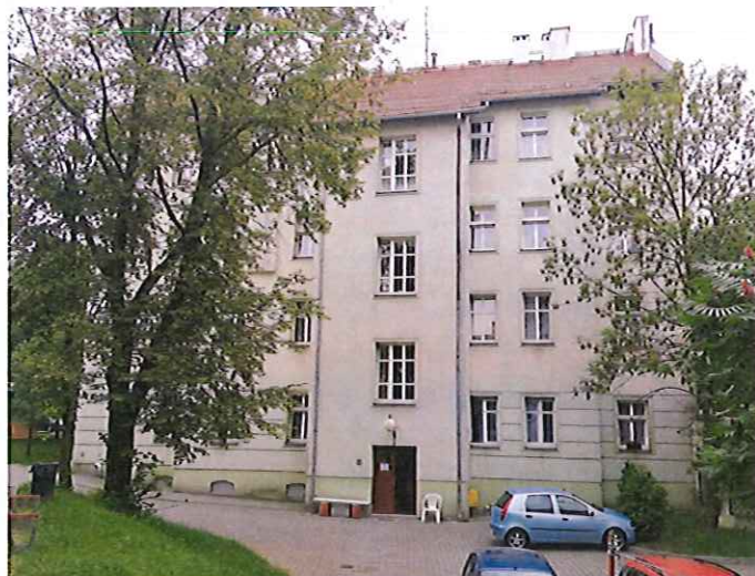
Fot. 2 Elewacja północna
