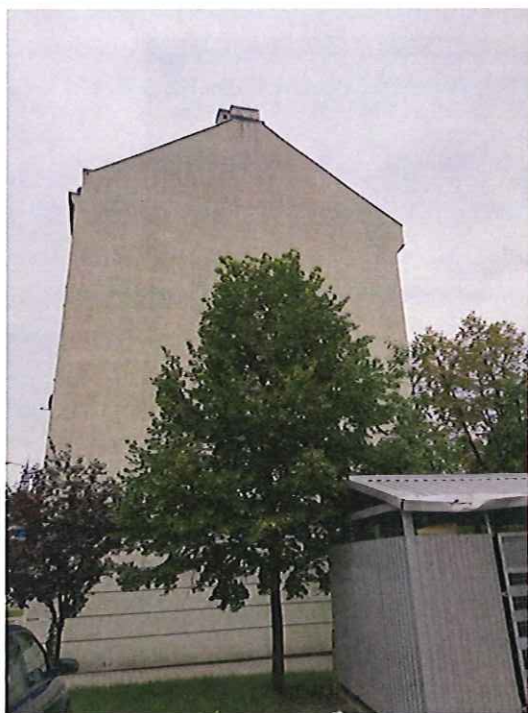
Fot. 3 Elewacja wschodnia
