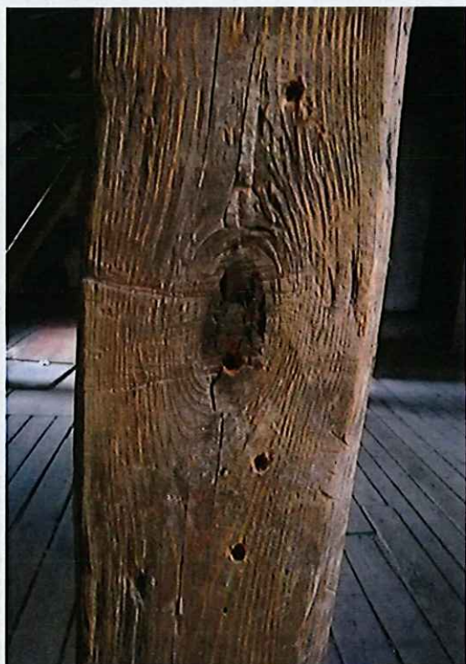
Fot. 13 Słup S7 - okrągłe otwory wylotowe owadów z rodzin kołatkowatych
