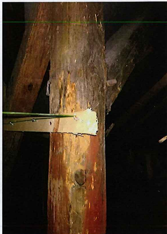
Fot. 20 Połączenie Słup S5, Zastrzał Z5, Miecz M5
