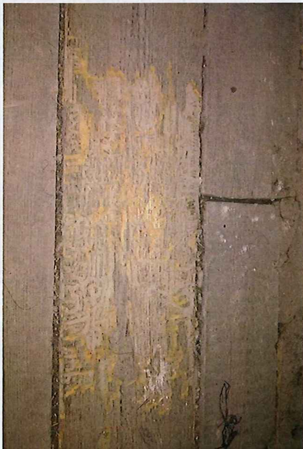
Fot. 5 Charakterystyczne wydrążone tunele
