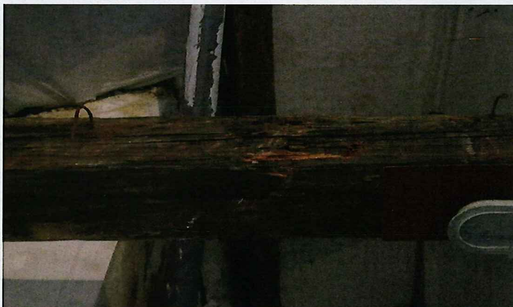
Fot. 23 Kleszcz Ks5 - Porażenie przez owady
