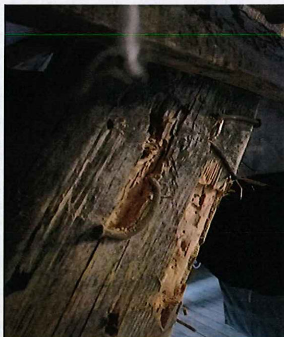
Fot. 16 Zastrzał Z9 - Efekt żerowania owadów Spuszczcza pospolitego
