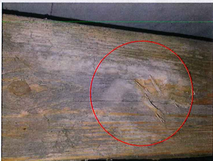
Fot. 22 Rozwijający się grzyb domowy biały, następujący rozkład drewna
