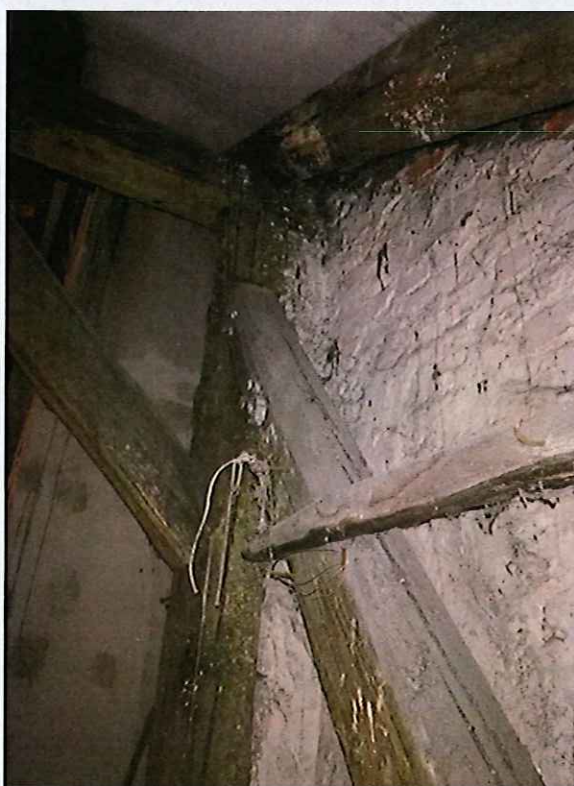
Fot. 10 Widok połączenia - Slup S1, Zastrzał Z1, Miecz M1. Krokiew K1 zaatakowana przez grzyb domowy biały.
