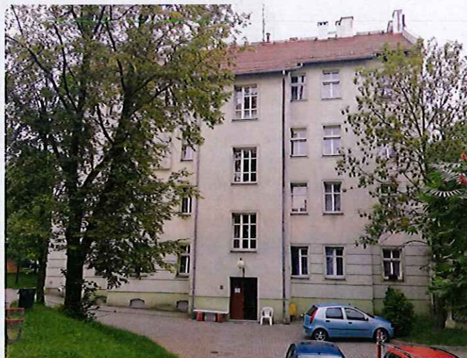
Fot. 2 Elewacja północna
