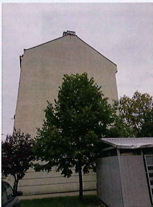
Fot. 3 Elewacja wschodnia
