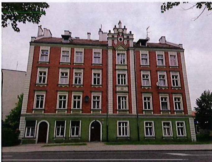
Fot. 1 Elewacja południowa (frontowa)
