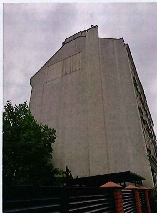
Fot. 4 Elewacja zachodnia
