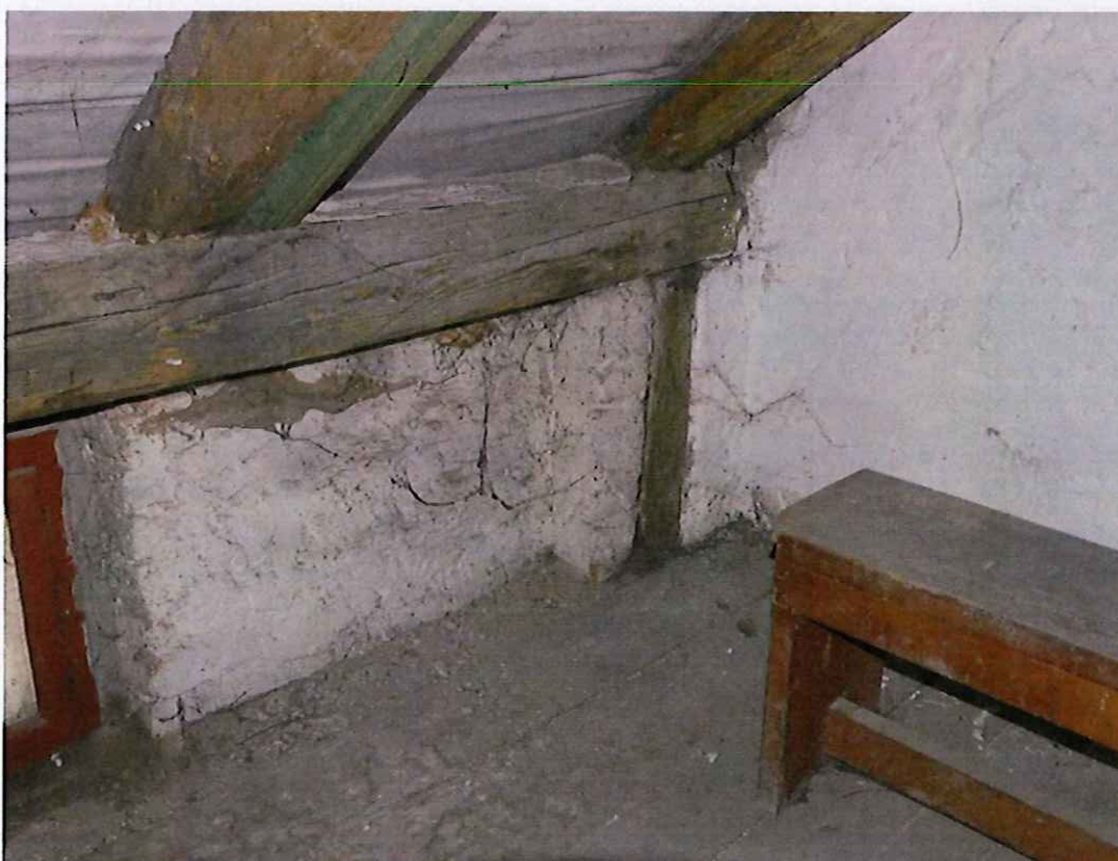
Fot. 9 Murlata M13 oraz krokwie K58, K57 zaatakowane przez grzyb domowy biały.
