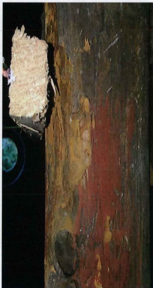
Fot. 26 Efekt żerowania kolatka domowego
