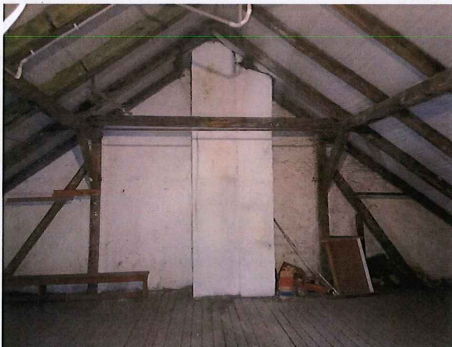
Fot. 5 Widok ściany szczytowej od strony zachodniej
