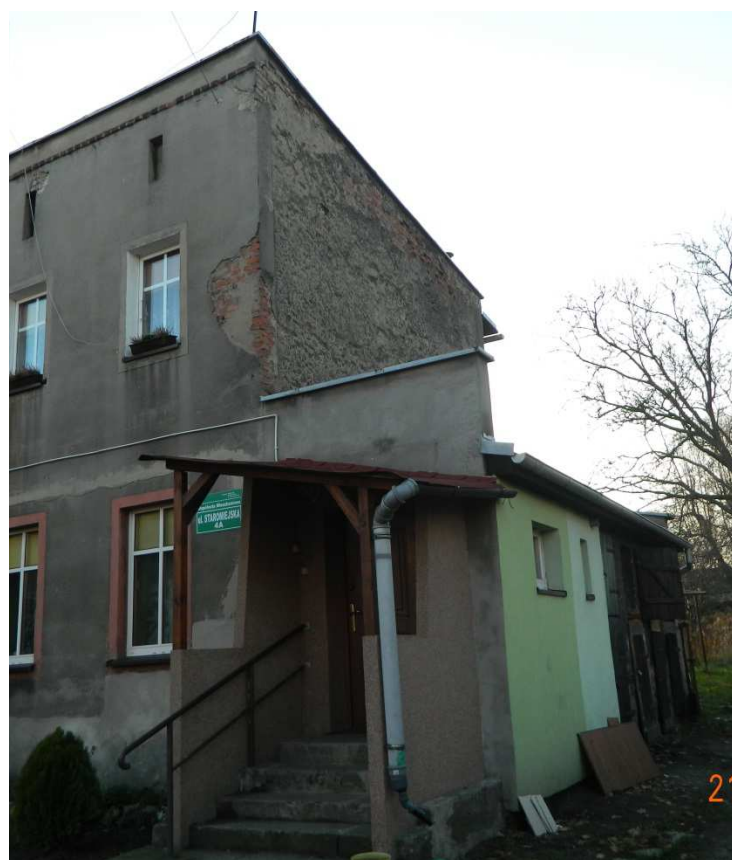
Fot. 3. Elewacja północna
