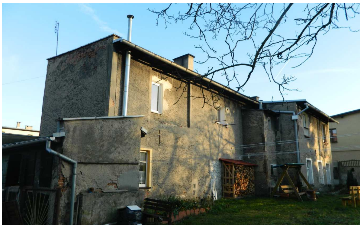
Fot. 2. Elewacja zachodnia
