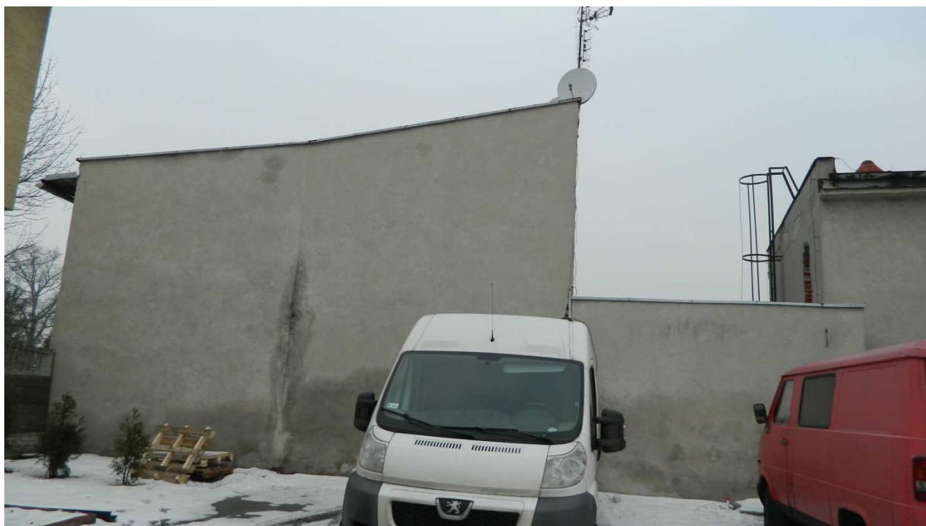
Fot. 4. Elewacja południowa
