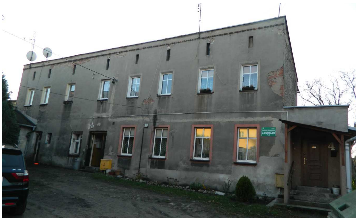
Fot. 1. Elewacja wschodnia
