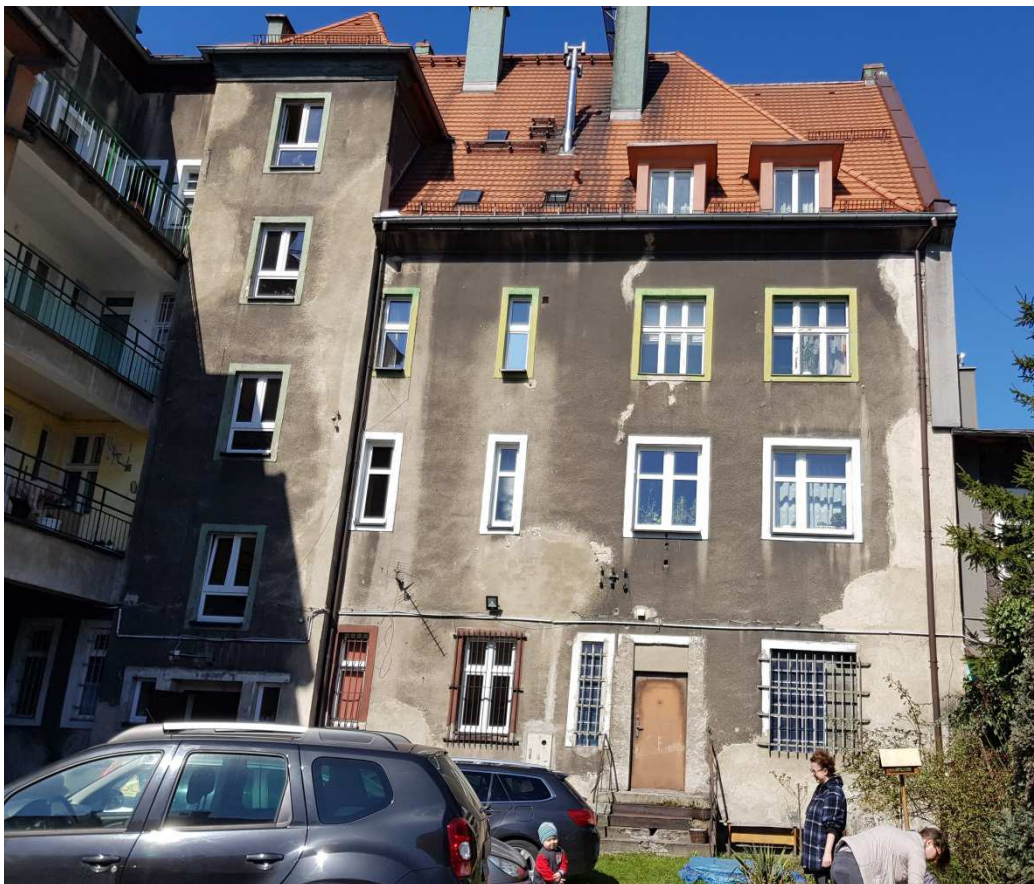
Fot. 5. Elewacja od podwórza – Lipowa 42
