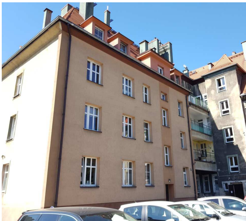
Fot. 3. Elewacja od podwórza – Żółkiewskiego 1
