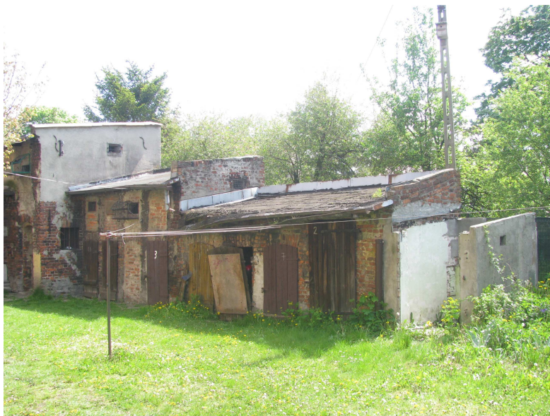
fot. 1-4 Budynki gospodarcze przewidziane do rozbiórki
